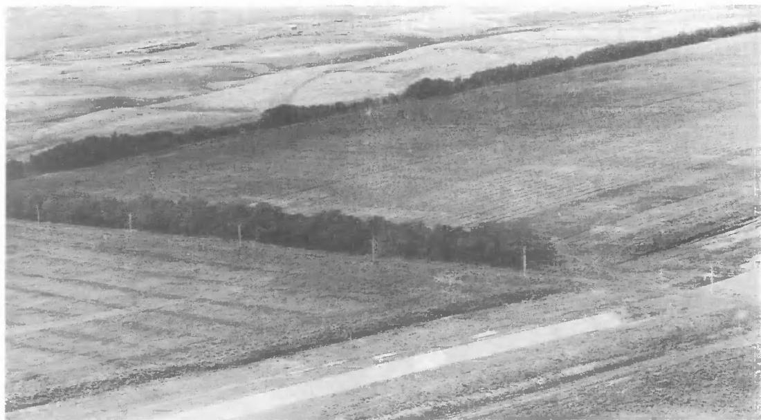
Лесные полосы. Расстояние между ними столь значительно, что они не обеспечивают задержание снега и не сдерживают эрозию. На переднем плане — строящийся канал Волга — Дон-2.
